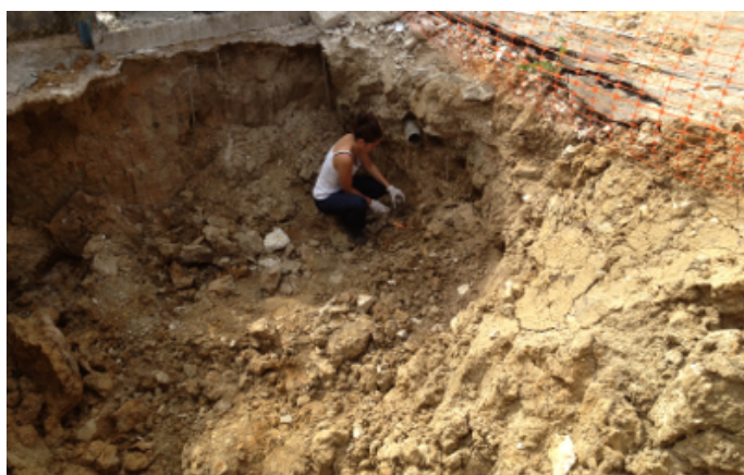
Maud, en chantier
